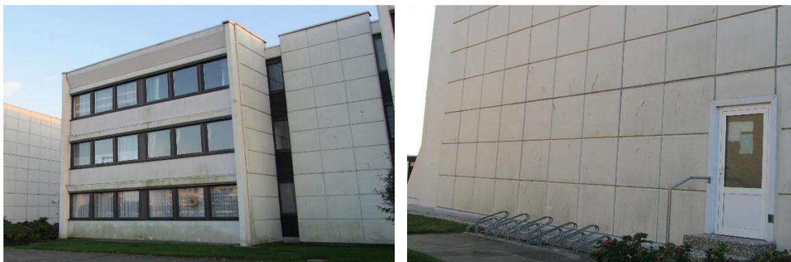
Abbildung 17 Appartementsanlagen: Substanzschwächen Fassade (complan Kommunalberatung, 2015)
